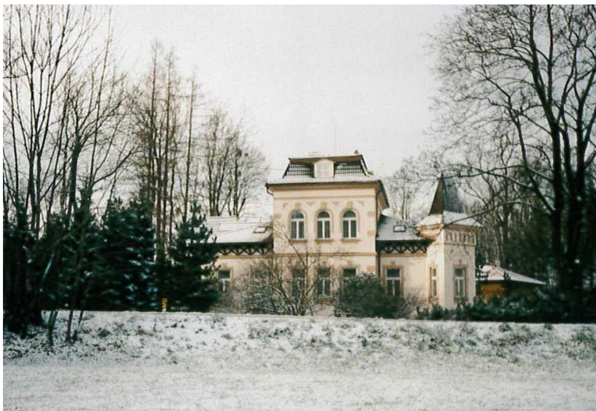
budova měšťanské školy po rekonstrukci, dnes Hotel Zámeček
